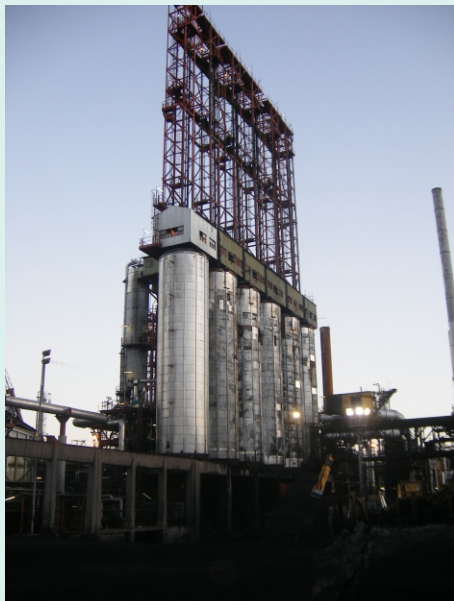
Fig - 1 - Tambores de coque
